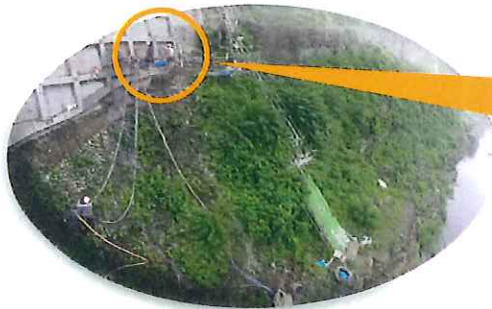
河川上部での施工事例 河川20m上部での排水ボーリング施工。
