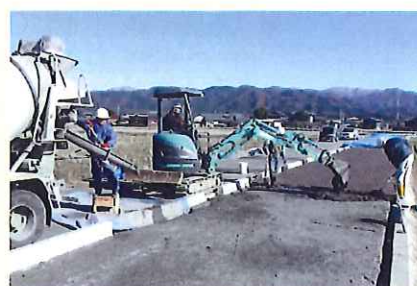
撒出し施工状況
