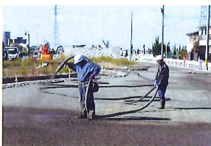
平地吹付施工状況
