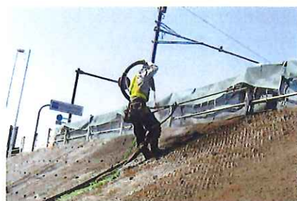
斜面吹付施工状況
