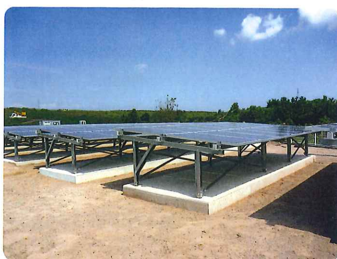
ソーラーパネル設置箇所
